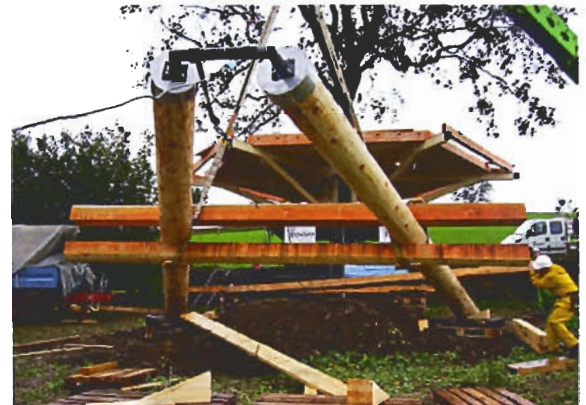
Der südwestseitige Balkon wird mit zwei «Hochstämmen» (hier bei der Aufrichtung) abgestützt (Bild oben). Für die Plattform wurden Bresta-Elemente verlegt.
