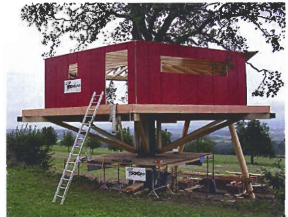
Der südwestseitige Balkon wird mit zwei «Hochstämmen» (hier bei der Aufrichtung) abgestützt (Bild oben). Für die Plattform wurden Bresta-Elemente verlegt.
