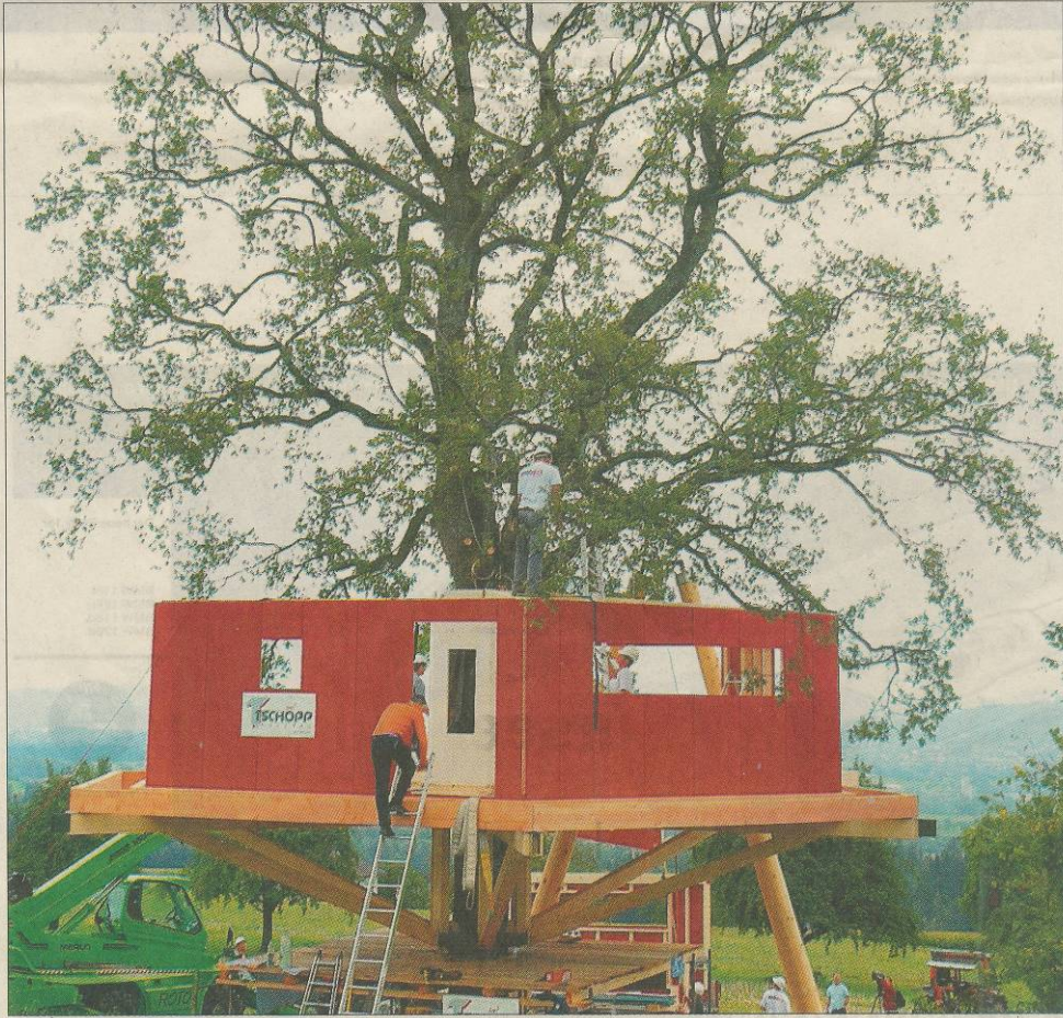
Seit gestern wird an der Eiche gearbeitet. Das Baumhaus wird im März eingeweiht.
